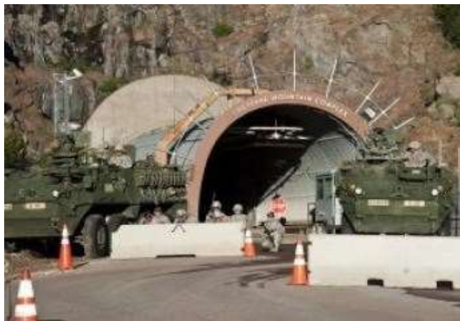
Entrée du complexe situé dans le Colorado.
